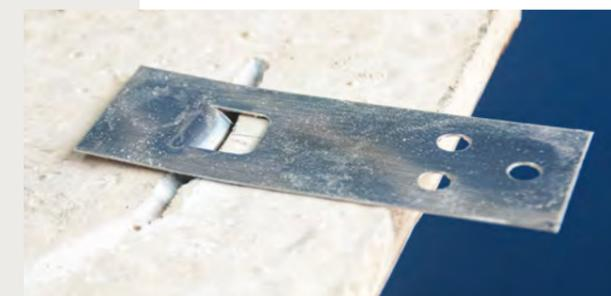
**04.** Realize o assentamento junto com o inserto e em seguida faça a furação da parede utilizando os 3 furos do inserto;
