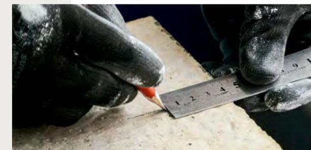
**02.** Crie o ângulo de 45° com a base da serra mármore e realize o corte de forma a assegurar uma cavidade leve e suficiente para encaixar o inserto metálico;
